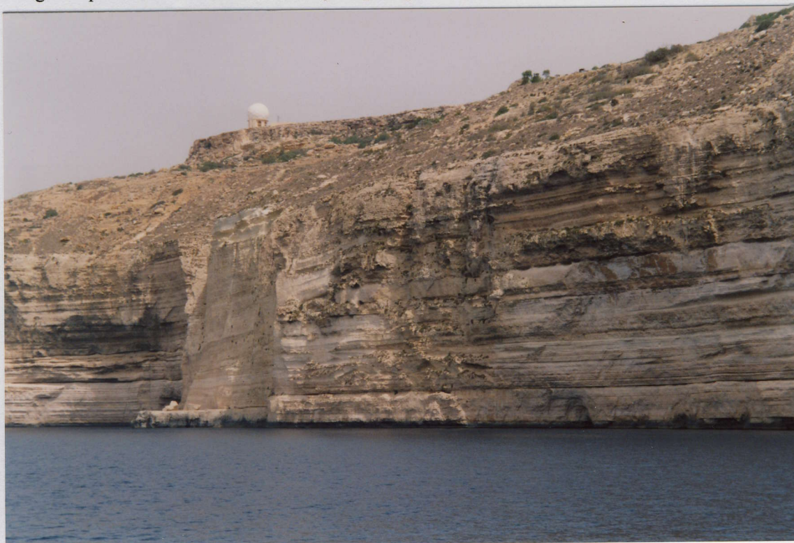
Radarstation op het begin van de Dingli Cliffs.
