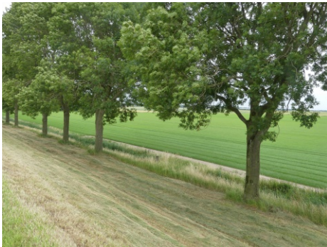
Polders aan de Buitendijk West.
