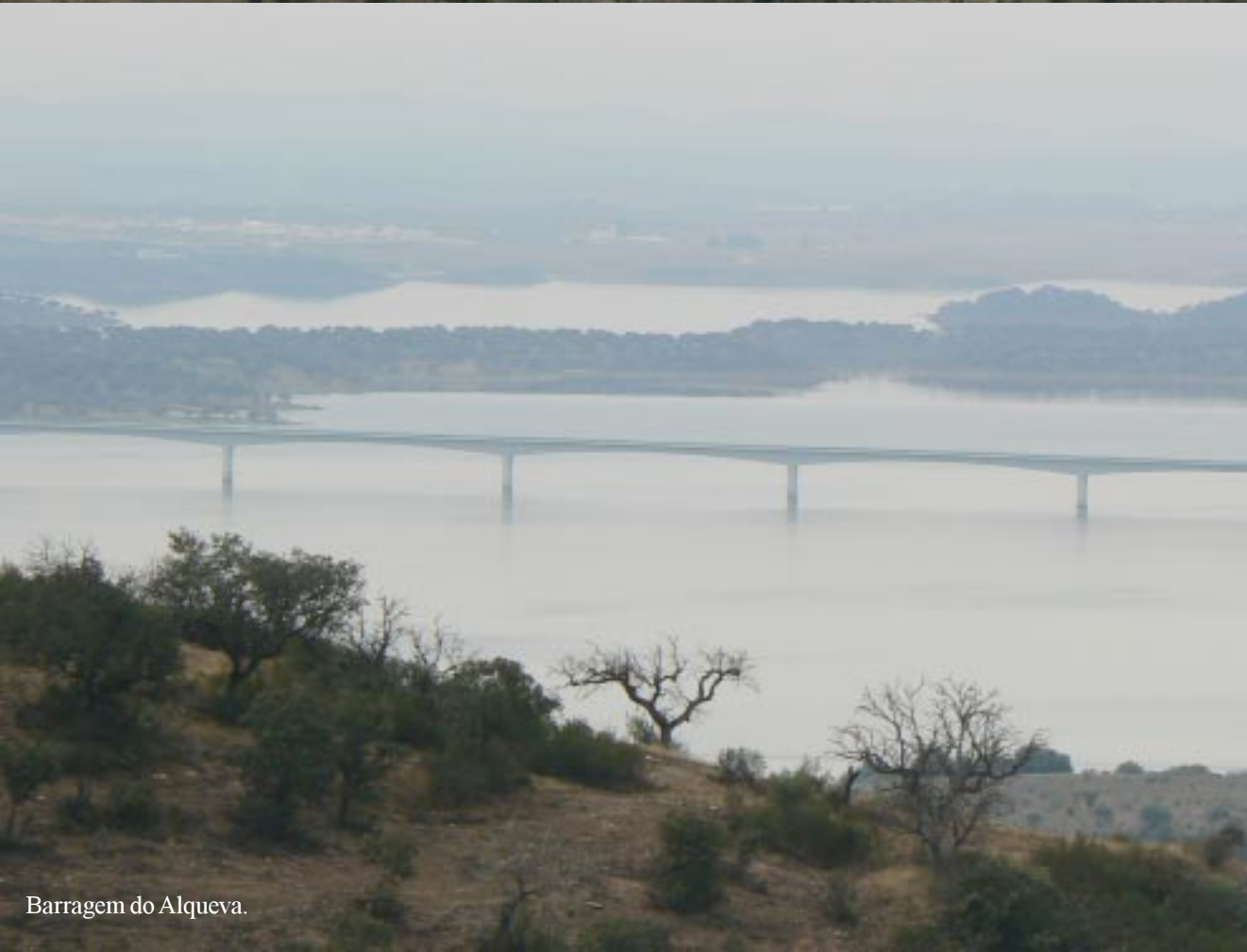
Barragem do Alqueva.
