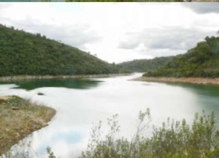
Barragem de Sta. Clara.
